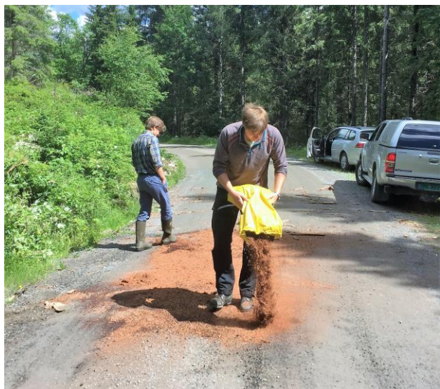
Utlekking av Zugol etter lekkasje av hydraulikkolje fra en tømmerbil.
